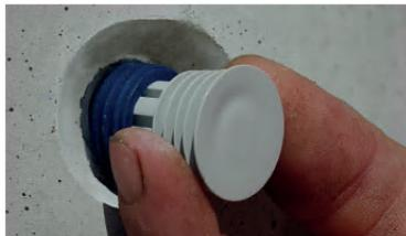
Positionner le bouchon d'étanchéité dans l'entretoise de coffrage
