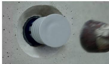
Taper le bouchon d'étanchéité dans l'entretoise de coffrage
