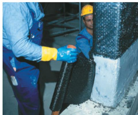
Application de MapeWrap sur l'élément en béton armé
