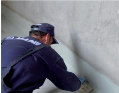
Mapelastic Foundation étalé à la truelle pour imperméabiliser l'eau en pression négative.
