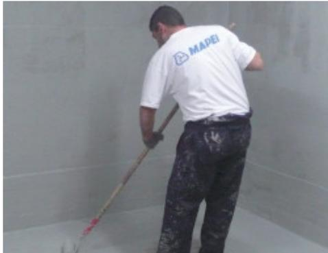
Mapelastic Foundation étalé au rouleau pour imperméabiliser l'eau en pression négative
