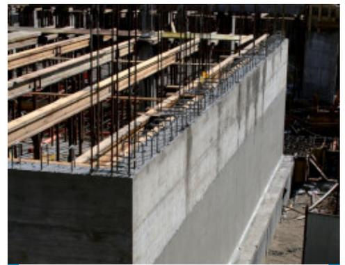
Mur de soutènement imperméabilisé après le coulage avec Mapelastic Foundation
