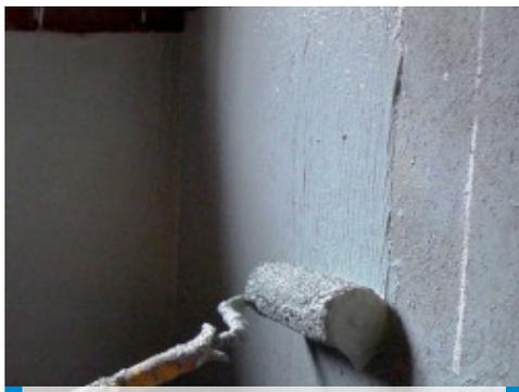
Application DEdeapelastic Foundation au rouleau sur un substrat lissé en utilisant Planitop HDM Maxi
