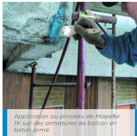
Application au pinceau de Mapefer 1K sur des armatures de balcon en béton armé
