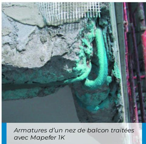
Armatures d'un nez de balcon traitées avec Mapefer 1K
