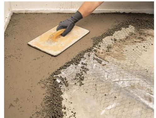
Recouvrement des tuyaux ou canalisations avec treillis métallique de renfort
