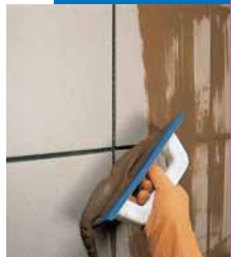
Jointoiment en façade à l'aide d'une spatule
