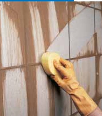
Finition des joints en mur à l'éponge
