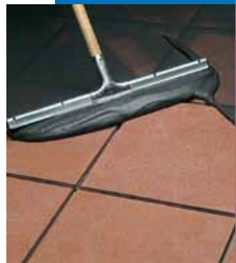
Jointoiment de terre cuite en sol à l'aide d'une raclette
