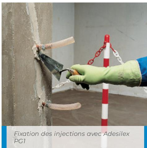
Fixation des injections avec Adesilex PG1
