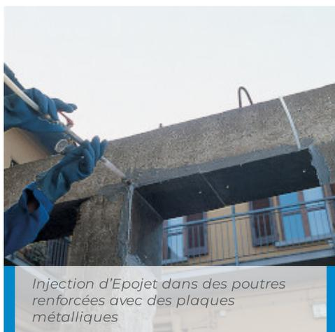
Injection d'Epojet dans des poutres renforcées avec des plaques métalliques
