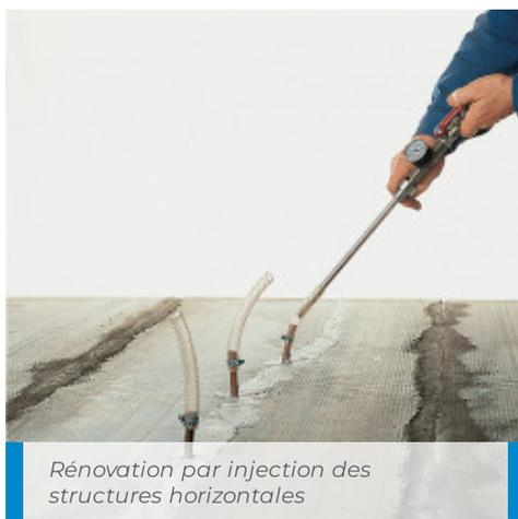
Rénovation par injection des structures horizontales
