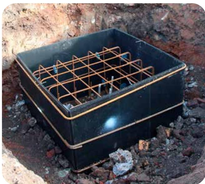
Déposer les Cof-massif<sup>®</sup> dans le fond de fouille, puis remblayer l'extérieur sur toute la hauteur si pas de cadre après avoir posé vos cales d'armature.
