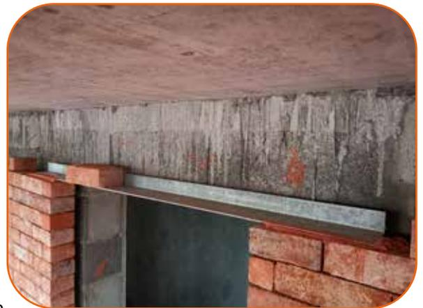
\*La cornière doit reposer sur une longueur minimale de 20 cm de chaque côté du linteau sur le doublage de maçonnerie.
